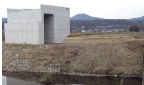
ブロック積工に変更される野崎川
