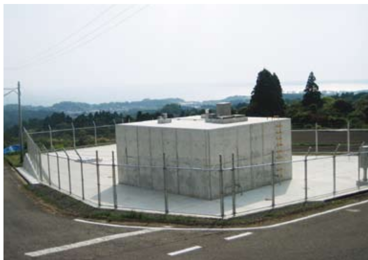
簡易水道のヲヤシ平配水池（頼娃）
