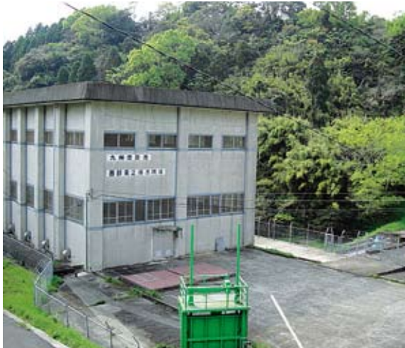
畑地かんがい西部第2揚水機場
