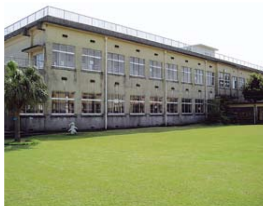
築54年経過した別府小学校
