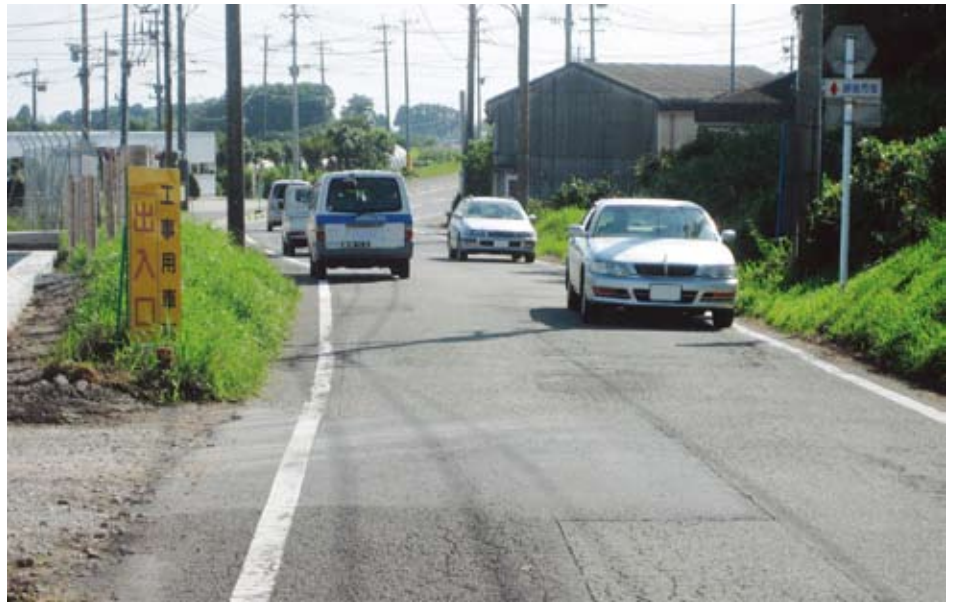
未整備区間の県道石垣喜入線
