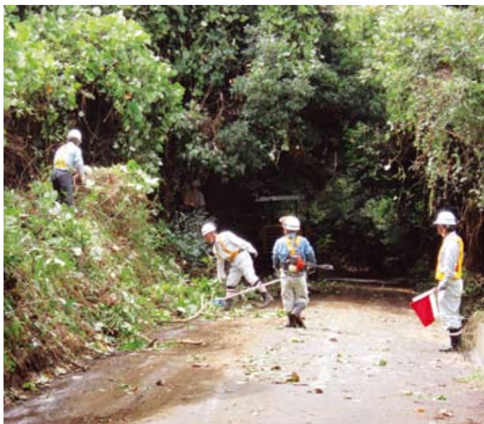
市道の草払いを行う作業員
