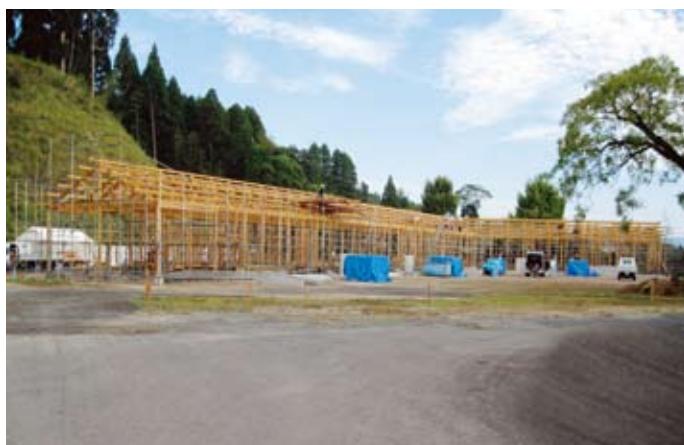
建設中の（仮称）勝目保育所
