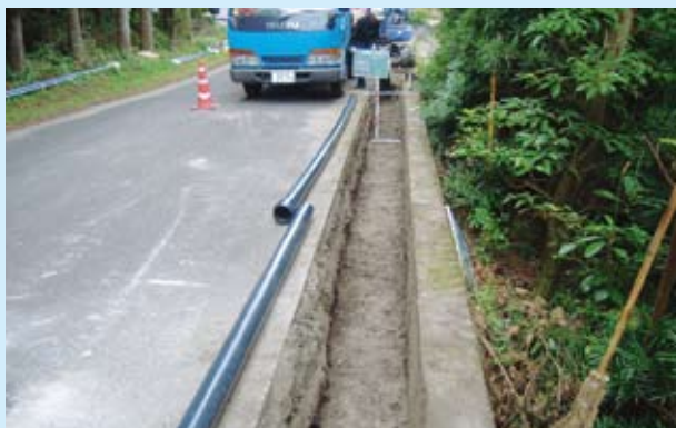
源川地区簡易水道の整備
