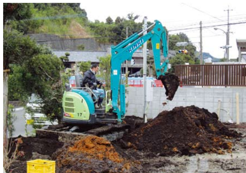
合併処理浄化槽の設置工事
