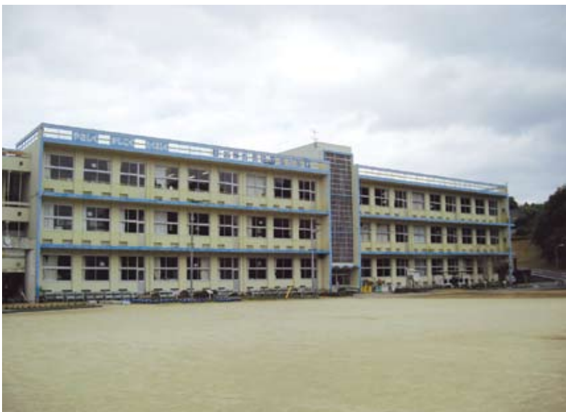
改修予定の川辺小東側校舎
