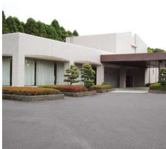
バス昇降所用屋根が設置される額娃浄楽苑
