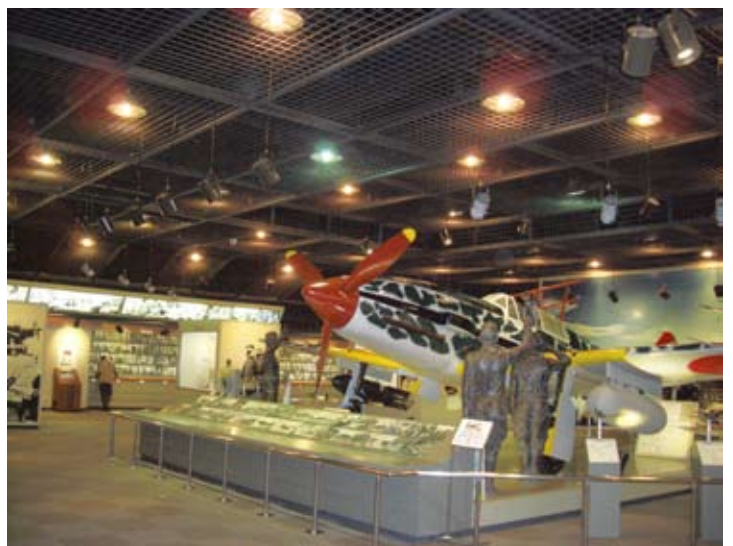
交換される平和会館の照明
