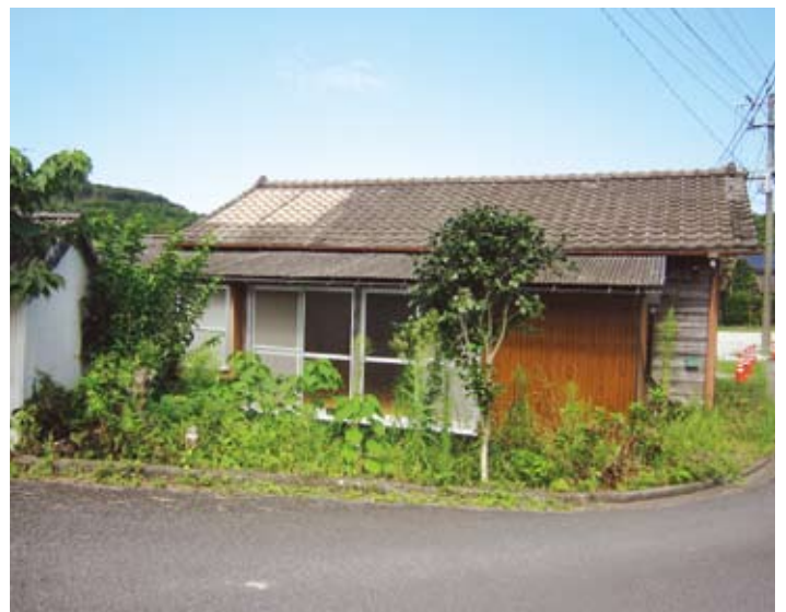
解体される両添住宅
