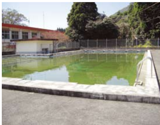
改修されるプール（手藁小学校）
