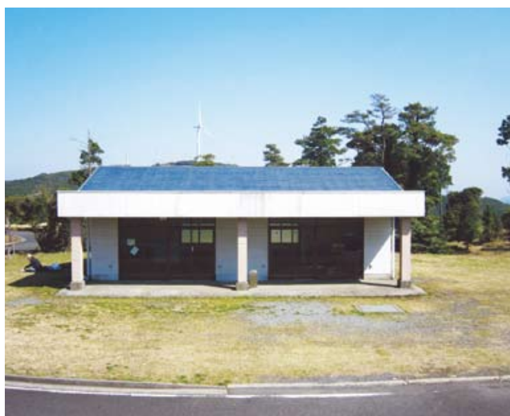
設備改修される農産物直売施設（アグリランドえい）
