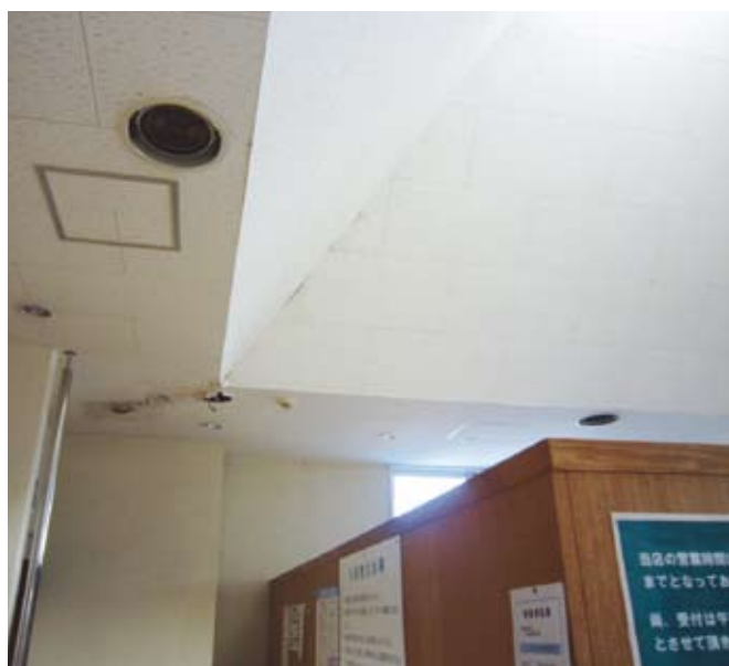
雨漏りの修繕箇所（ふれあいセンターわくわく川辺）
