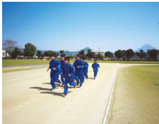
改修される陸上競技場（額娃運動公園）
