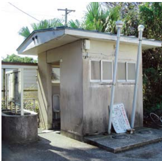
改修される西穎娃駅トイレ
