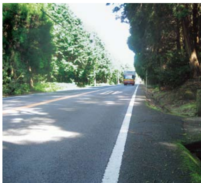
歩道整備が望まれる永里浮辺線
