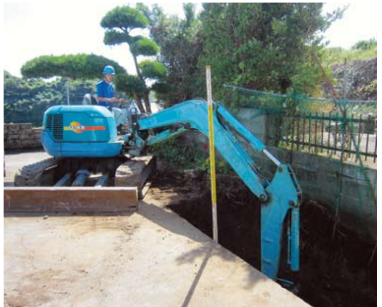
地元業者による浄化槽設置工事
