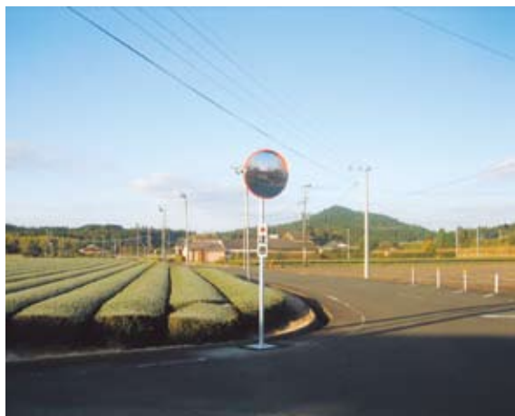
新設されたロードミラー
