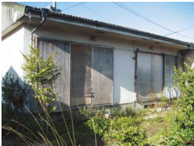
解体される牧之内団地
