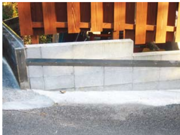
民家に設置されているヤスデ返し
