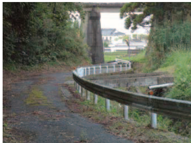
避難道路として整備が待たれる市道
