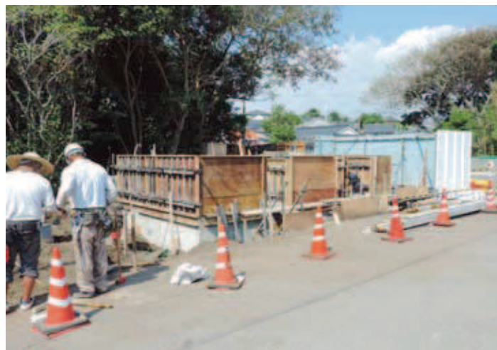
釜蓋神社近くに建設中のトイレ
