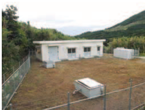
整備された嶽地区水源地
