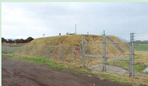
簡易水道事業から水道事業へ統合される松永配水池
