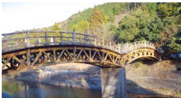
改修される岩屋公園の平安橋
