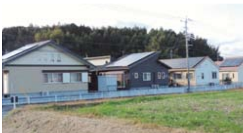
太陽光発電を導入した住宅
