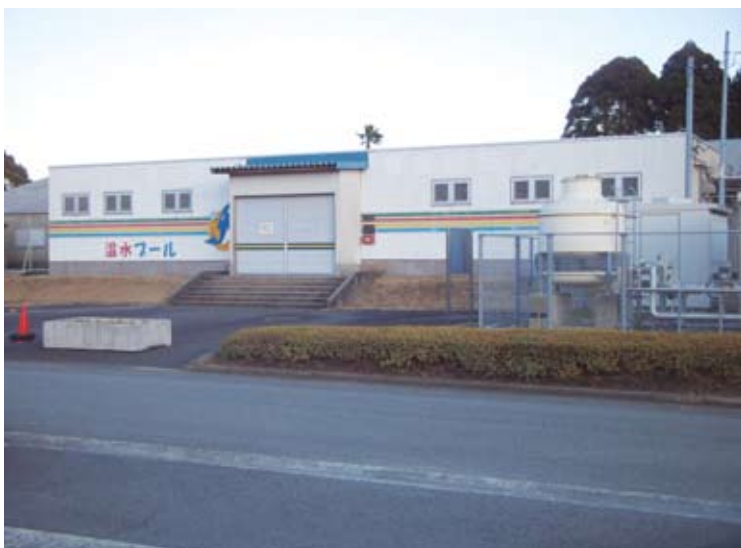
B & G海洋センター温水プール
