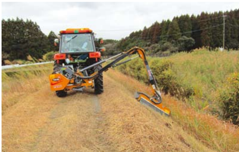
乗用型草刈り機による伐採作業
