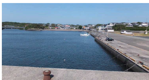
浚渫予定の大川港
