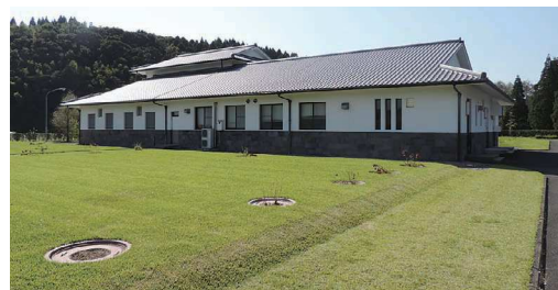
知覧中央浄化センター
