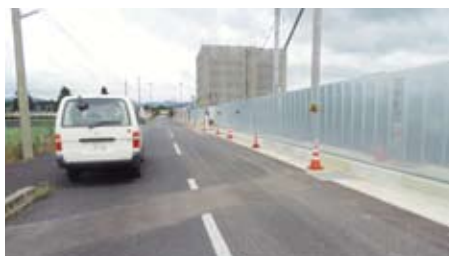
管渠拡張工事予定地
