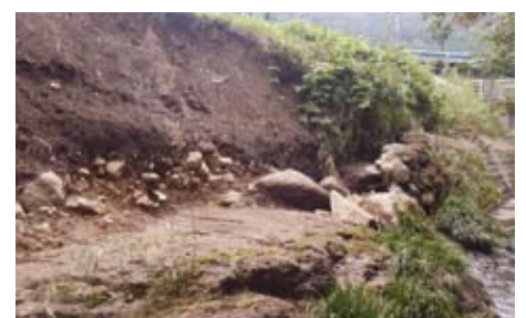
台風16号で崩落した河川
