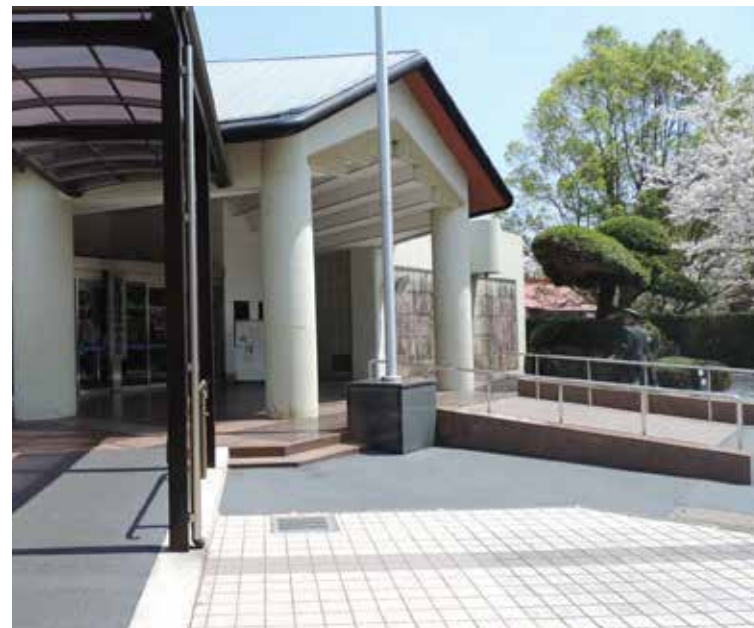
バリアフリー化された平和会館入口
