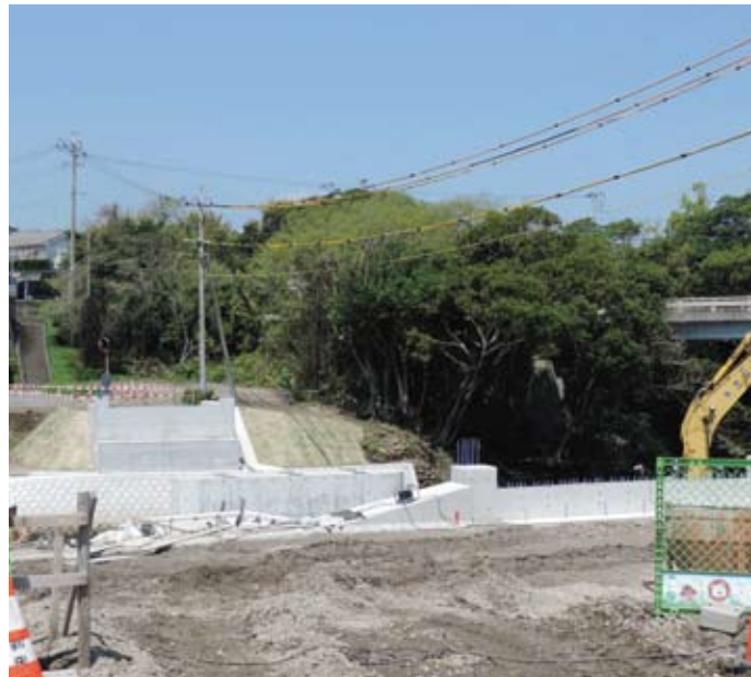
竹迫橋の架替工事
