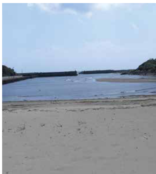
大川漁港の土砂堆積
