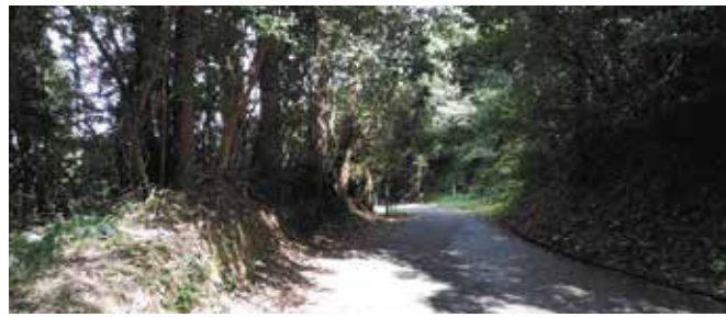
幅員が狭く見通しの悪い市道（瀬世松崎線）
