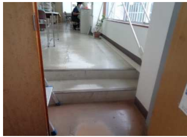
西別館入口段差
