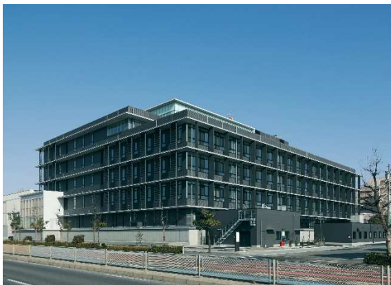
庇バルコニー・ルーバーを設置した事例（半田市庁舎） 太陽光パネルをルーバーに用いた事例（瑞穂町庁舎）
