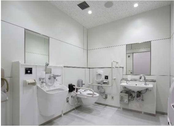
多目的トイレの事例（北本市庁舎）
