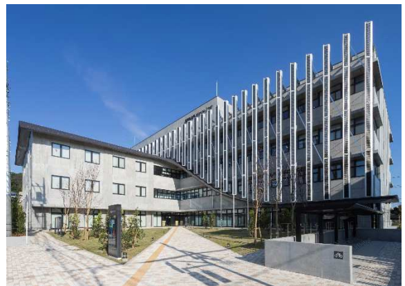
庇バルコニー・ルーバーを設置した事例（半田市庁舎） 太陽光パネルをルーバーに用いた事例（瑞穂町庁舎）
