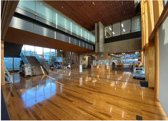
内装を木質化した事例（出水市庁舎）
