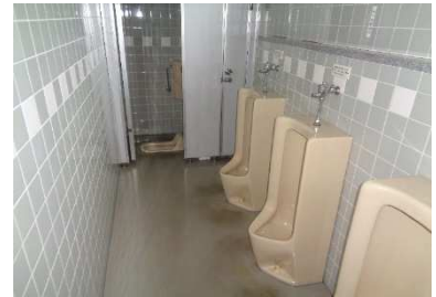
東別館 トイレ(3階男子)
