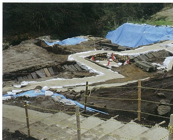
発掘調査中の金山水車跡
