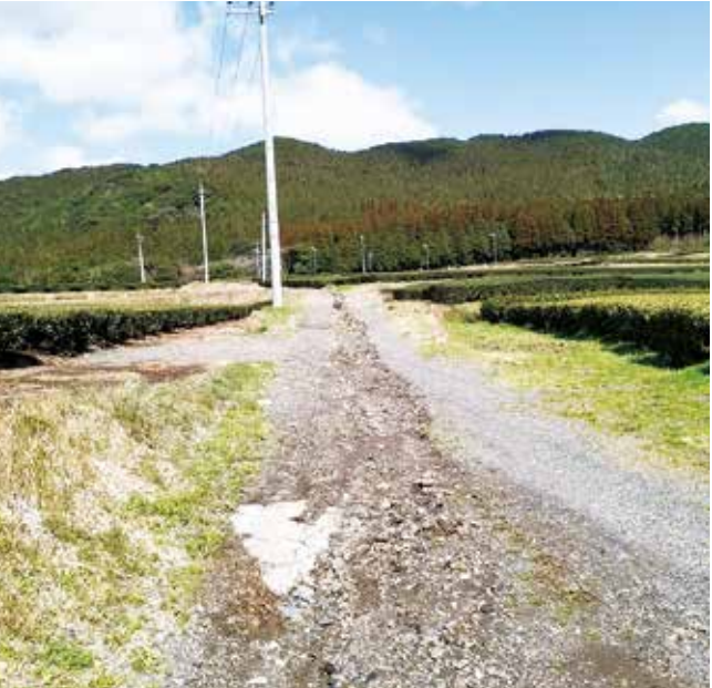
整備が必要な農道（折尾地区）
