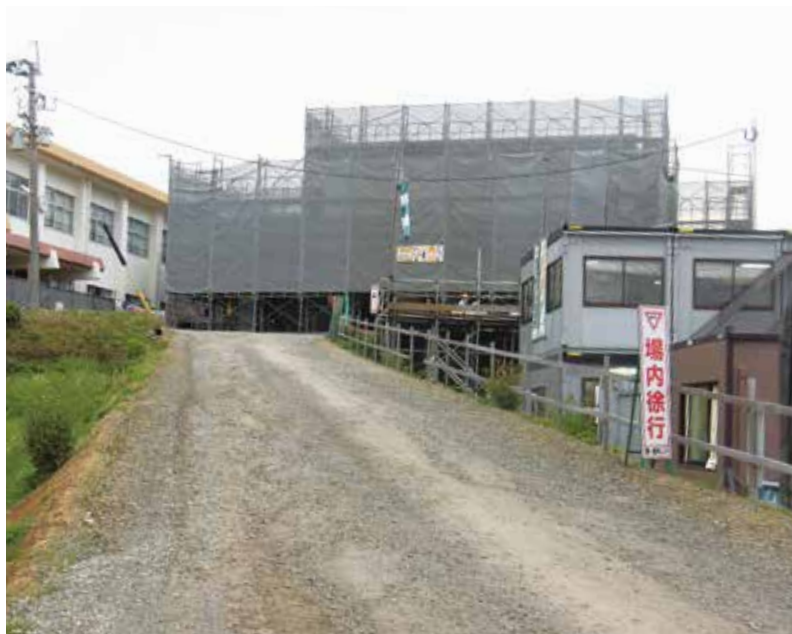
統合に向け、工事中の顕娃中学校
