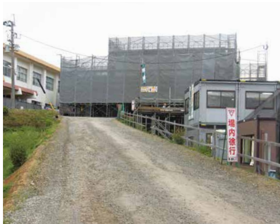
統合に向け、工事中の頤娃中学校
