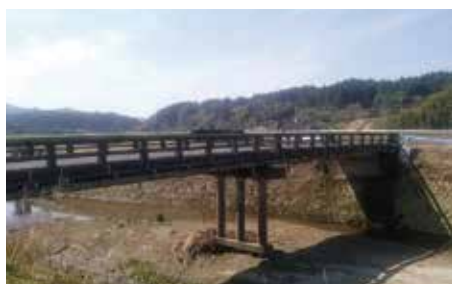
橋りょう補修(有村橋)
