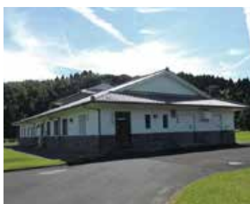
知覧浄化センター
