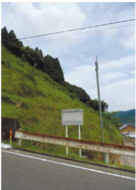
県が指定する急傾斜地崩壊危険区域
