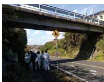
水成川跨道橋
