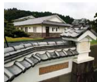
知覧中央浄化センター
