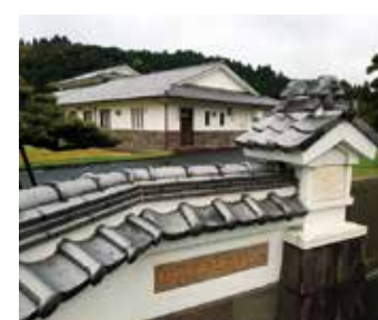
知覧中央浄化センター
