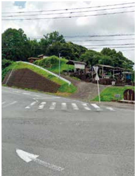
自転車通学生の事故を受け、本年7月に合同点検を行った三差路（川辺町永田）
