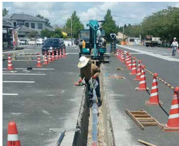
水道施設の更新
