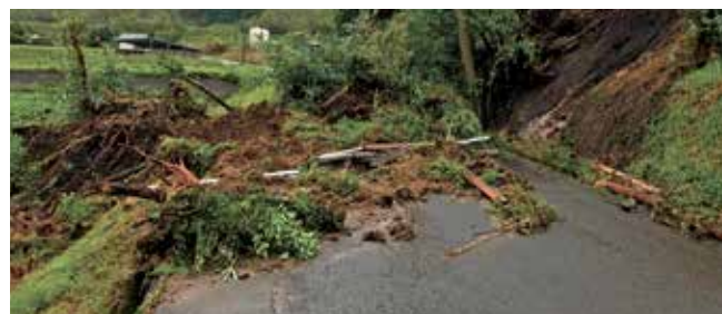
法面が崩れた市道
