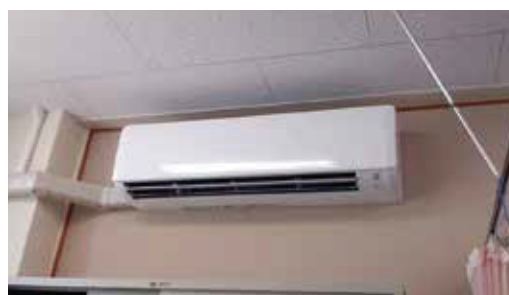
小学校空調設備移設
