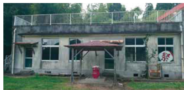
解体予定の園舎
