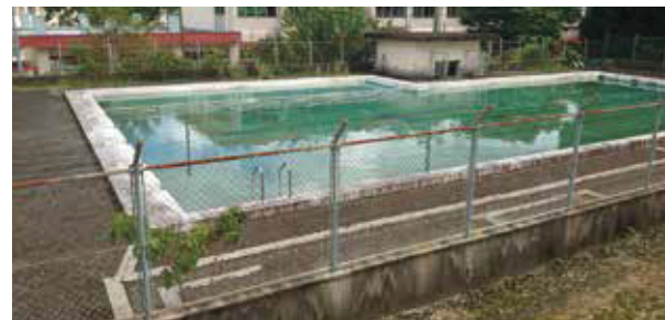
解体予定のプール
