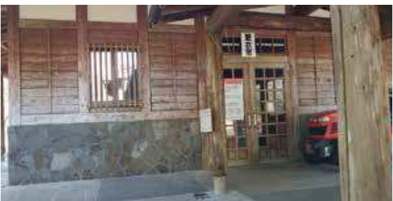
岩屋公園の更衣室 (シャワー室の改修)
