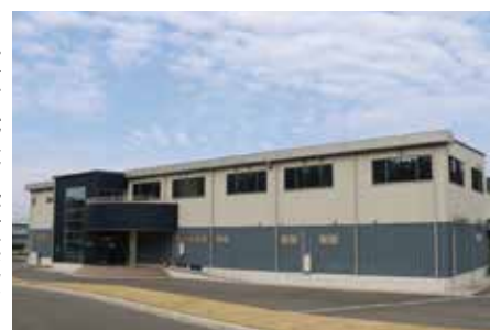
増設された第3工場
