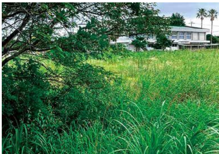
旧青戸中学校の状況
