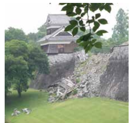
熊本地震災害（熊本市）
