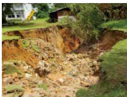
旧長谷小学校の土砂流出による陥没状況
