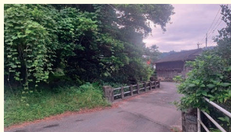
市道山脇伊瀬知線 伊瀬知橋（2級河川高取川）
