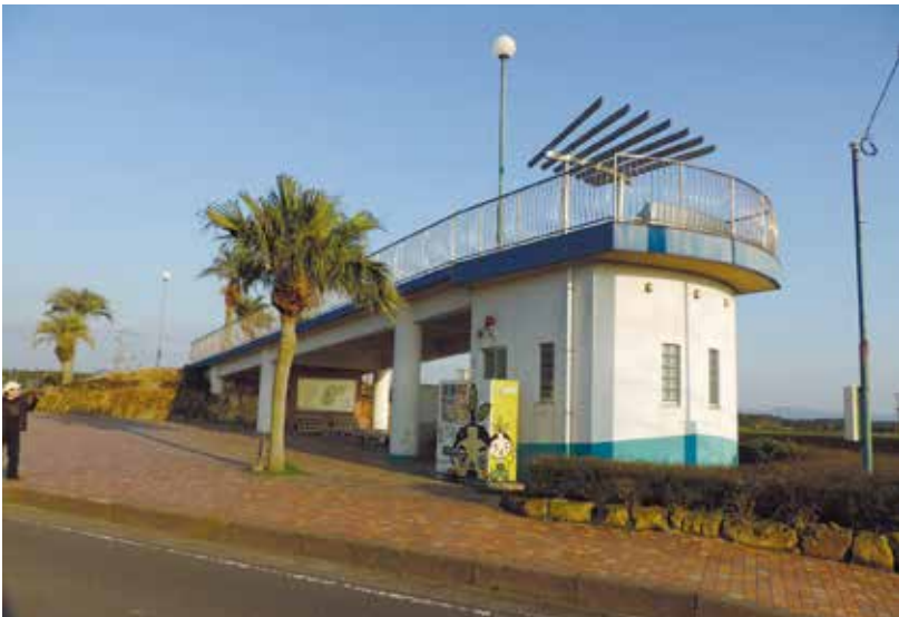
多目的トイレが設置してある松山マザーパーク
