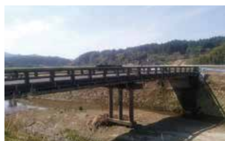
橋りょう補修(有村橋)
