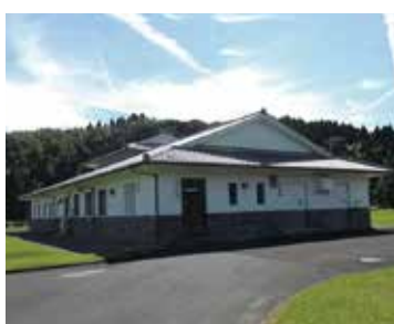
知覧浄化センター
