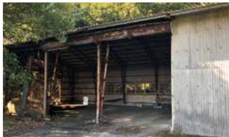
解体される農機具格納庫（熊ヶ谷放牧場）
