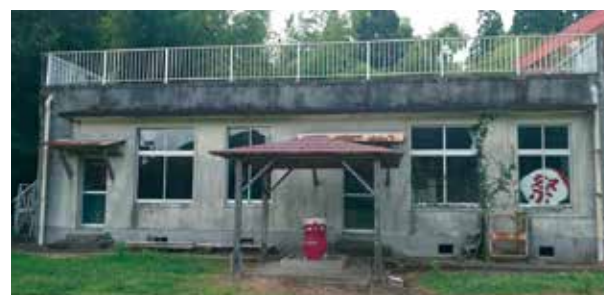
解体予定の園舎
