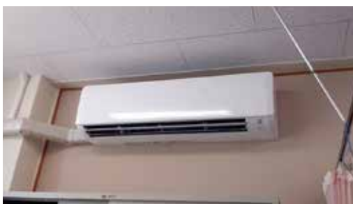
小学校空調設備移設
