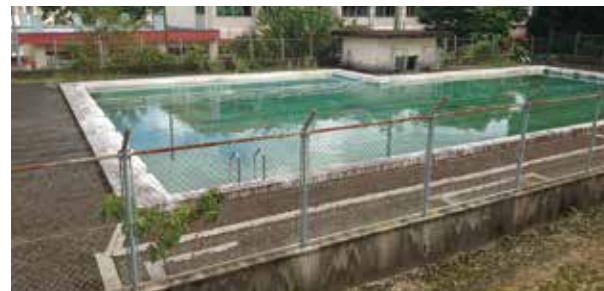
解体予定のプール
