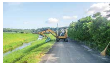
重機を使用した作業（大谷川）
