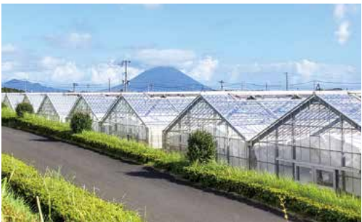
硬質プラスチックハウス（顕娃農業開発研修センター）
