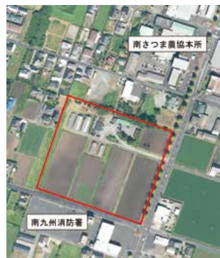
新庁舎建設予定地
