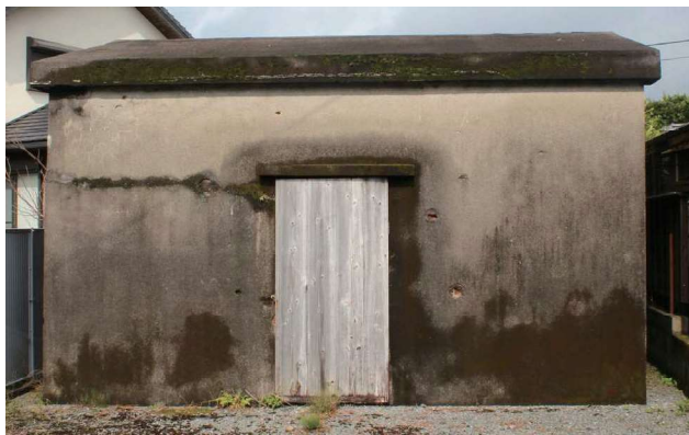
写真 2-18 旧知覧飛行場油脂庫
