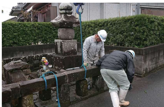
写真5-3 破損した文化財の修理
