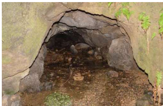
写真4-13 田代金山坑道
