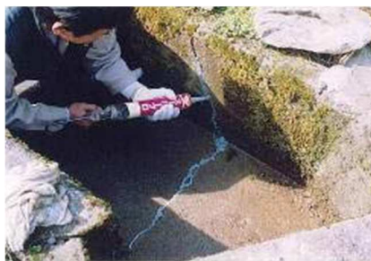
水路のひび割れ補修
