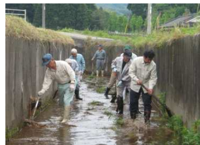
水路の泥上げ
