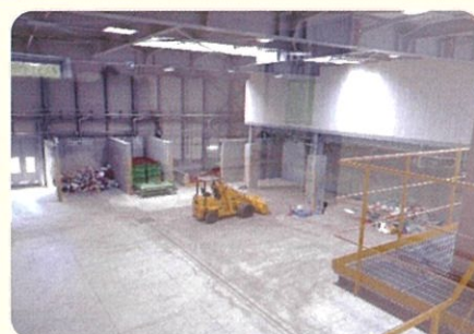
粗大ごみ処理施設 プラットフォーム
