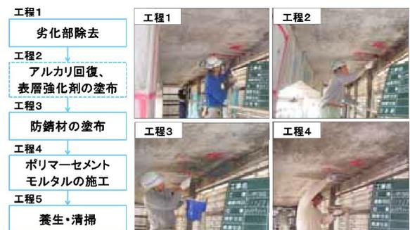
鉄筋腐食によるひび割れの補修事例
