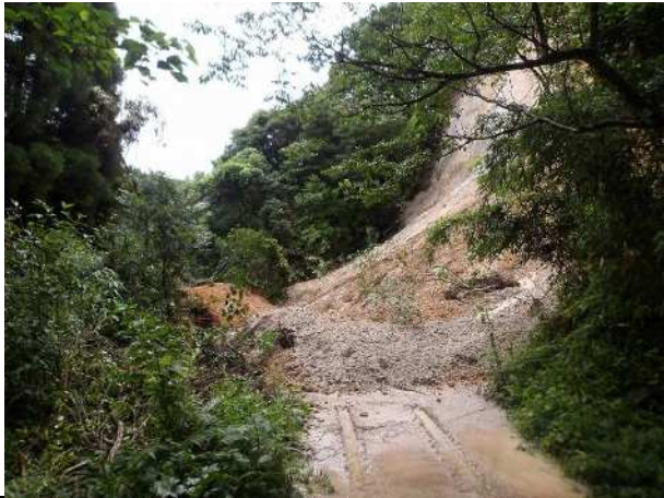
農道崩土(崩土除去)
