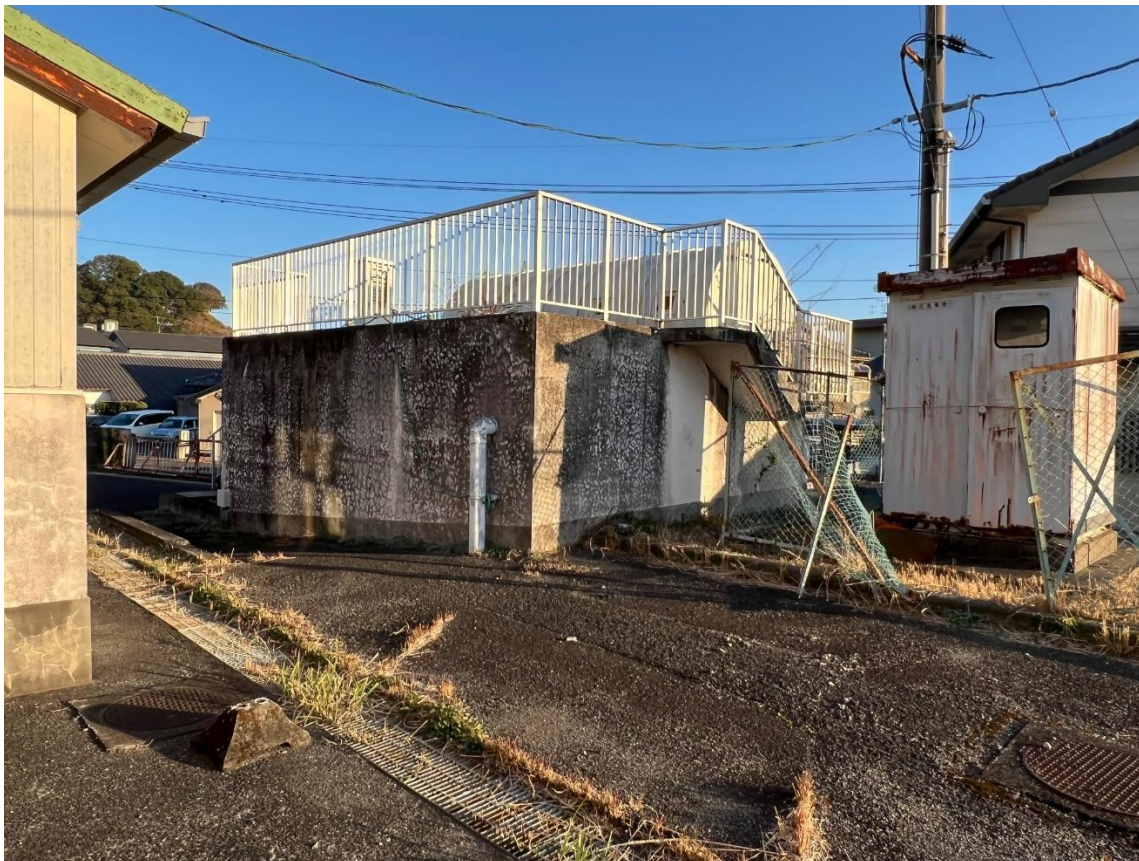
旧川辺学校給食センター 付帯設備(左:浄化水槽 右:キュービクル)
