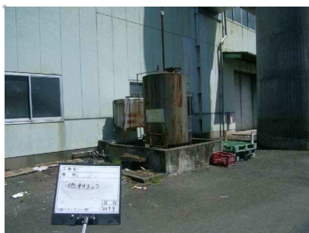
写真 4 燃料タンク 地上式タンクで重油を保管していた。
