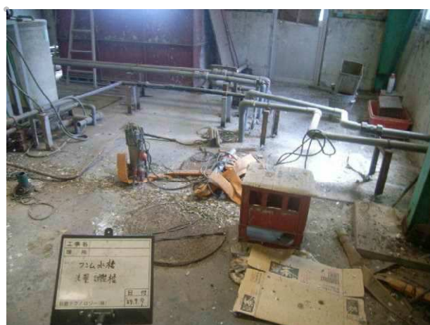
写真26 排水処理室 流量調整槽に排水は貯められ、処理後の水は噴霧水槽に送られる。 噴霧水槽の水はガス冷却装置の冷却水に利用する。
