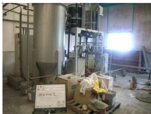
写真26 排水処理室 施設内の排水を処理して、冷却水として利用している。
