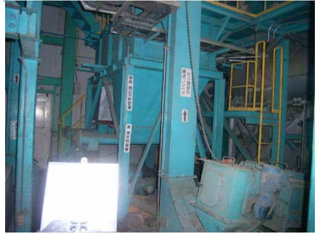
写真27 ダイオキシン処理プラント 灰貯留槽
