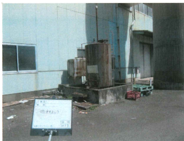
写真4 燃料タンク 地上式タンクで重油を保管していた。
